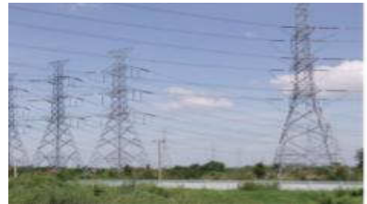
เสาไฟฟ้า
