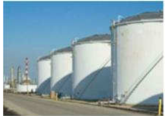
ถังเก็บน้ำมันบนดิน
