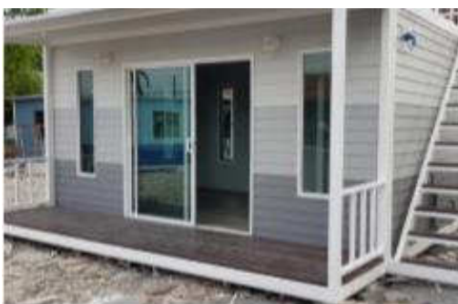
บ้านประกอบเสร็จ
