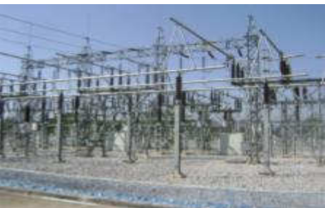
สถานไฟฟ้า
