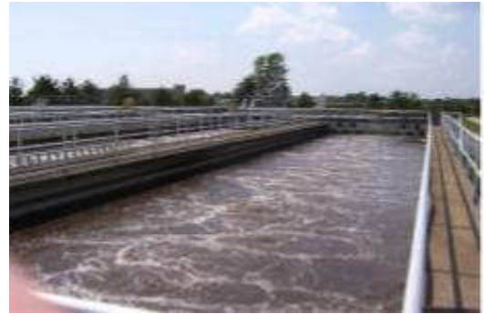
บ่อน้ำบำบัดน้ำเสีย
